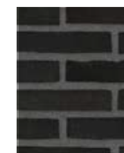
Tegel i livfull mörkgrå. Ingjutes i betongelement med varierande förband.
